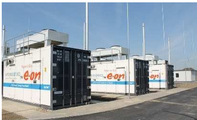
Konténerekben elhelyezett elektrolizálókat.
