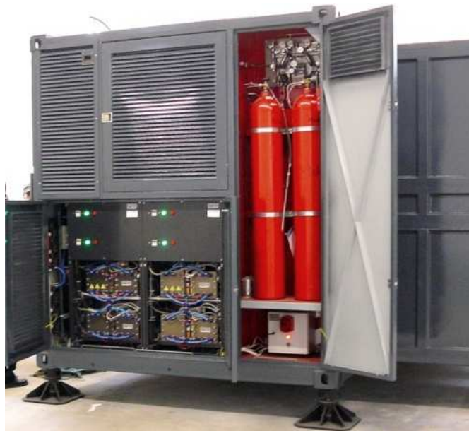
Az FCH 8000 berendezés és a hidrogén lefejtő rendszer elhelyezése a 20'-as konténerben (Fuel Cell Hungary Kft.)
