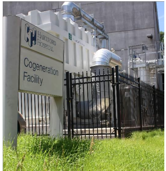
1,4 MW e teljesítményű tüzelőanyag-cellás CHP egység a Hartford Kórház udvarán (kép: Fuel Cell Energy)
