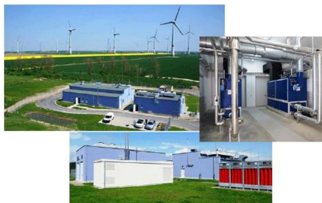
Illusztráció: a németországi Grapzow – 2013 óta működő – PtG létesítménye, 1 MW-os (Hydrogenics) elektrolizáló teljesítménnyel, egy 140 MW-os szélenergia-park mellett.
