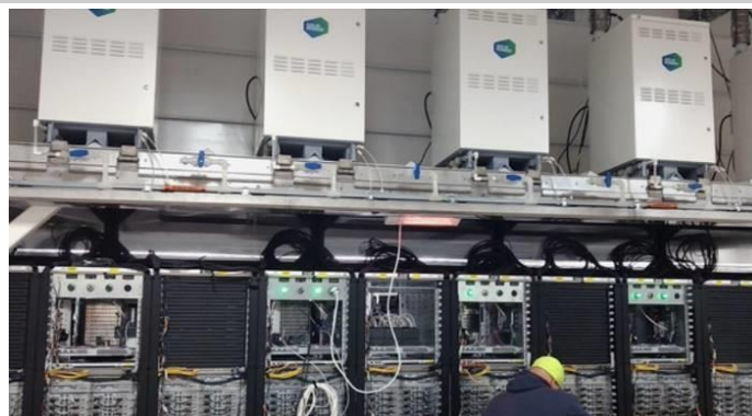
Tüzelőanyag-cellák a Microsoft Seattle-i adatközpontjában, közvetlenül a szerverek felett. (Kép: Solidpower)
