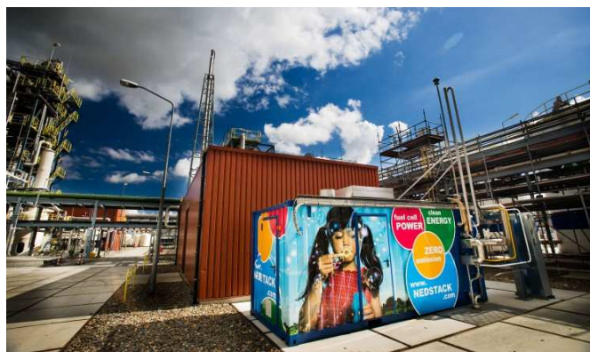
Előtérben az 1 MW-os PEM FC konténer a Solvay gyárában.
