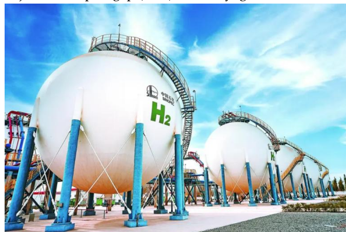
Hidrogéntároló tartálypark egy kínai finomítóban. Kép: Sinopec
