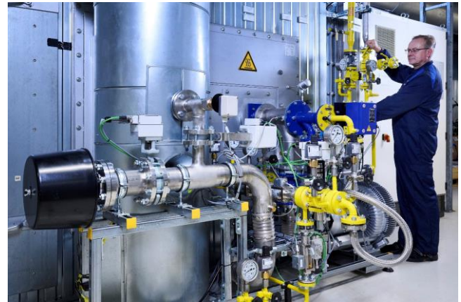
Üzemanyag-flexibilis ipari gázégő a BMW lipcsei festőüzemében. Kép: BMW Group.
